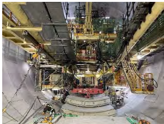
シールドマシン後方設備の状況 (令和7年11月24日)
