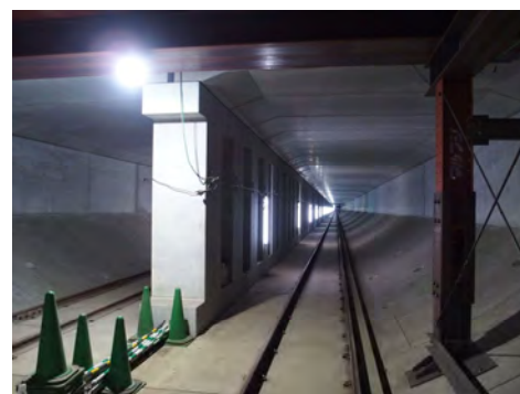
内部構築工・仮設床版の状況 (令和7年12月4日)
