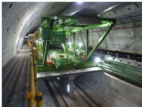
トンネル内の内部構築施工設備の状況 (令和7年12月4日)
