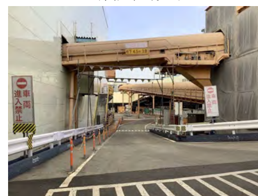
立坑地上部・連続ベルトコンベア (令和7年12月2日)
