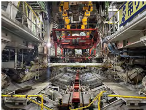
切羽付近のシールドマシンの状況 (令和7年12月3日)
