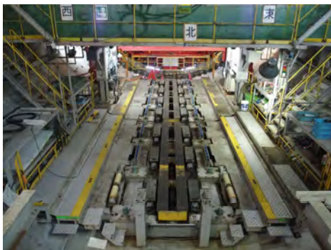
セグメントを供給する装置の状況 (令和7年12月4日)
