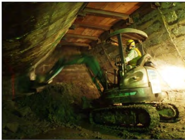
下半中央部掘削 油圧ショベル【低騒音型・低振動型】
