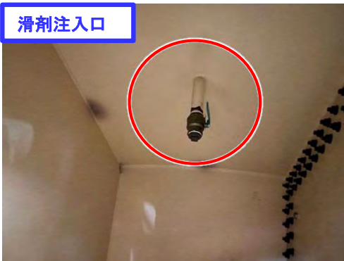
滑剤充填設備(東名JCT Aランプシールドトンネル工事の状況)
