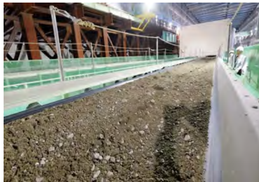
掘削した土砂をベルトコンベヤーで搬送する状況 (令和5年12月21日)
