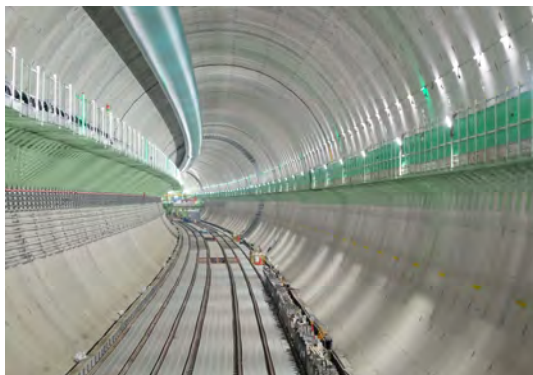
構築されたトンネル内(RCセグメント) (令和7年9月27日)
