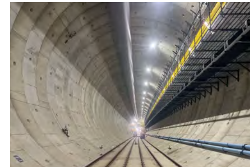
構築されたトンネル内(RCセグメント) (令和7年12月9日)
