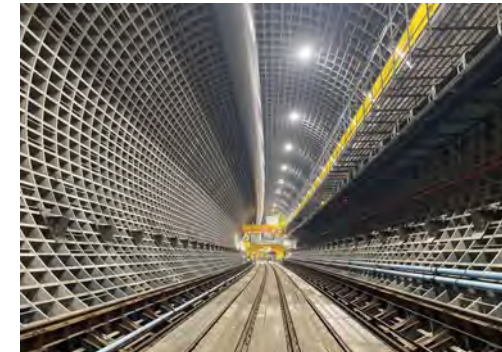
構築されたトンネル内(鋼製セグメント) (令和7年12月9日)
