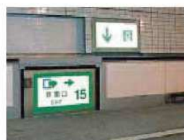
路面下への非常口(路面から)
