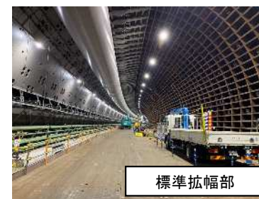
東名JCT地中拡幅(南行)の現地状況
