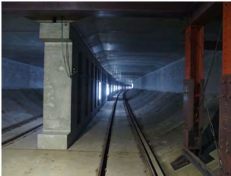
内部構築工・仮設床版の状況 (令和7年7月23日)
