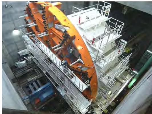
シールドマシンの組立状況 (令和2年9月25日)
