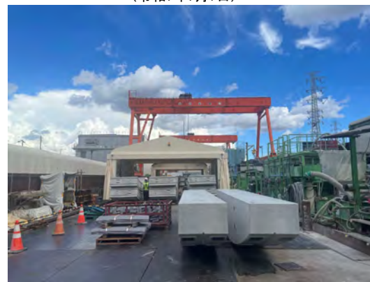
セグメントストックヤードの状況 (令和7年7月7日)
