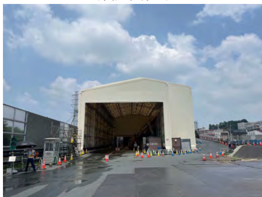
土砂ピットヤードの設置状況 (令和7年7月7日)
