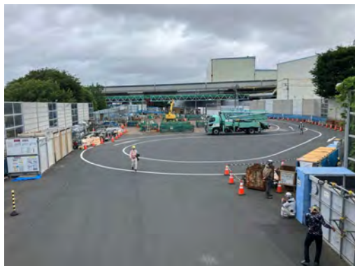
換気所地下工事の地上部 左岸野川下流部から望む (令和7年7月15日)
