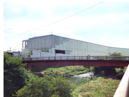
土砂ピットヤードの全景写真 (令和7年7月1日)
