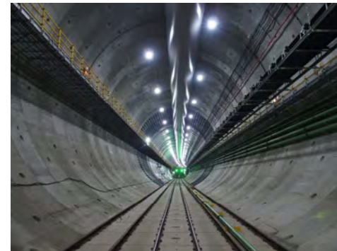
トンネル内の状況 (令和7年7月23日)
