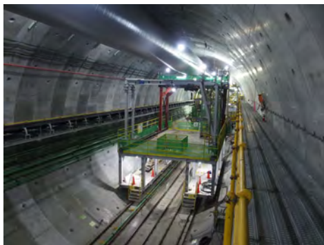
トンネル内の状況 (令和7年7月23日)
