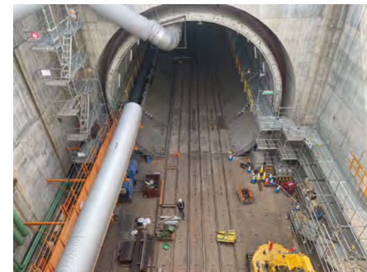
発進立坑部の状況 (令和7年7月7日)
