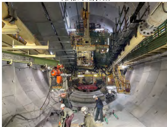
シールドマシンの状況 (令和7年7月7日)
