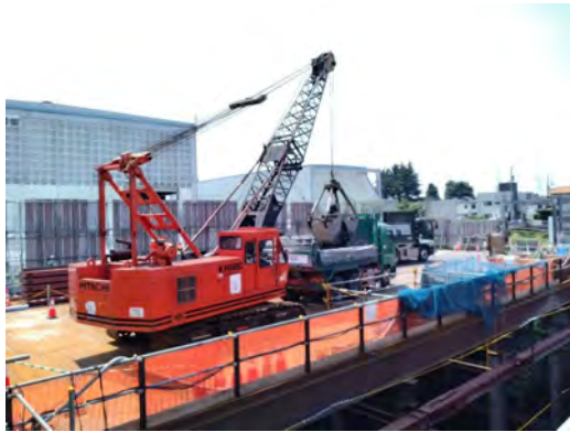
Hランプ工事 水道道路付近から南方向を望む (令和7年7月23日)
