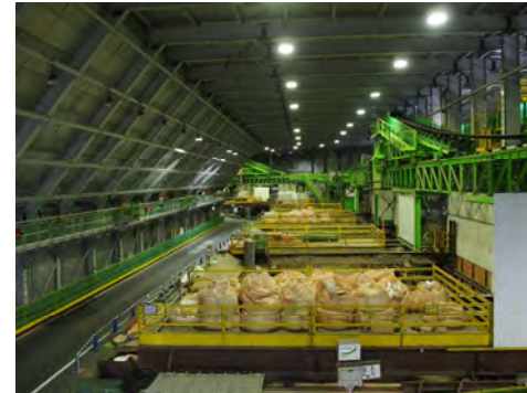
土砂ピットヤード内部の状況 (令和7年7月23日)
