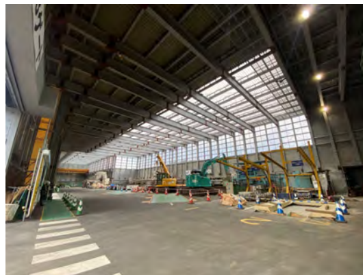
土砂ピットヤードの内部状況 (令和7年7月23日)
