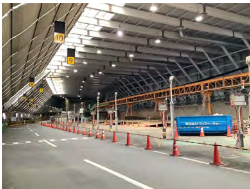
土砂ピットヤードの内部状況 (令和7年7月1日)
