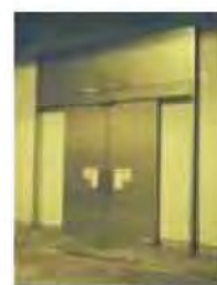
首都高速中央環状新宿線の例
