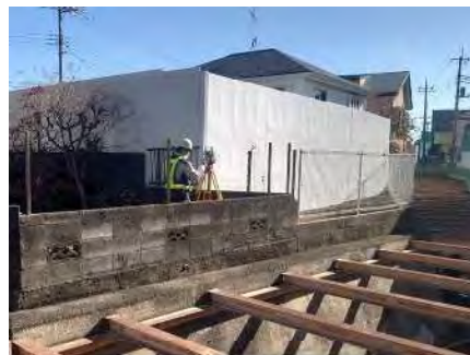
変状調査（測量）
