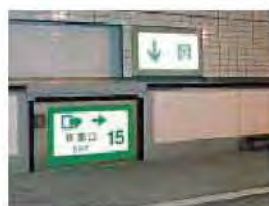
路面下への非常口(路面から)
