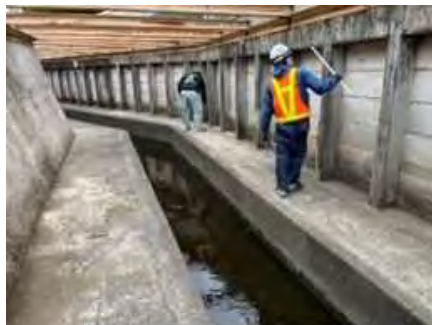
変状調査（点検）
