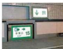
路面下への非常口(路面から)
