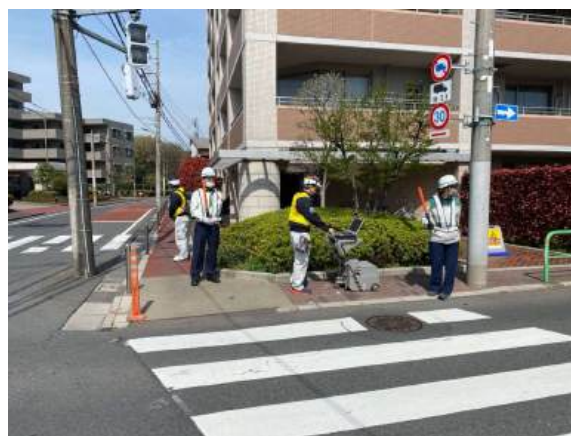
路面下空洞調査(歩道部)
