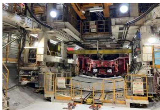
掘進状況 (令和7年7月25日)
