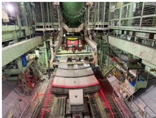
セグメント組立状況 (令和7年7月25日)
