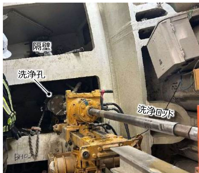
高圧洗浄の作業状況
