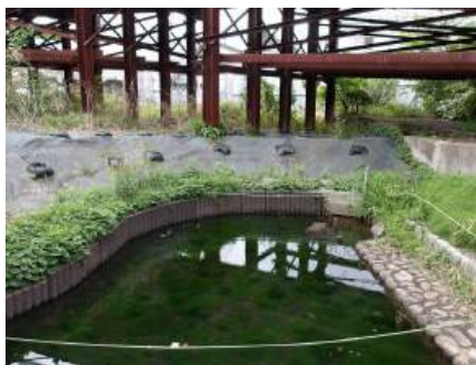
土砂流入防止措置の状況 (R7.4)
