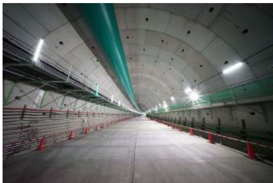
床版構築状況 (令和5年11月21日)
