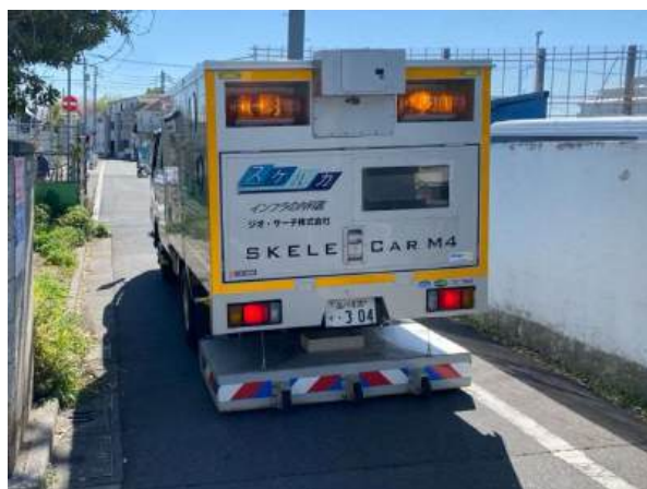
路面下空洞調査(車道部)
