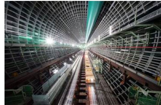
構築されたトンネル内(鋼製セグメント) (令和7年7月25日)
