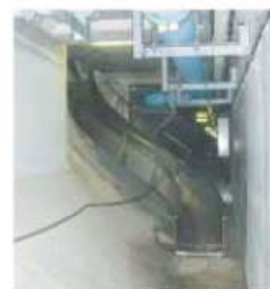
すべり台(路面下から)
