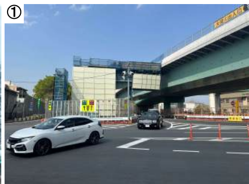
送出し架設前 (令和5年4月)
