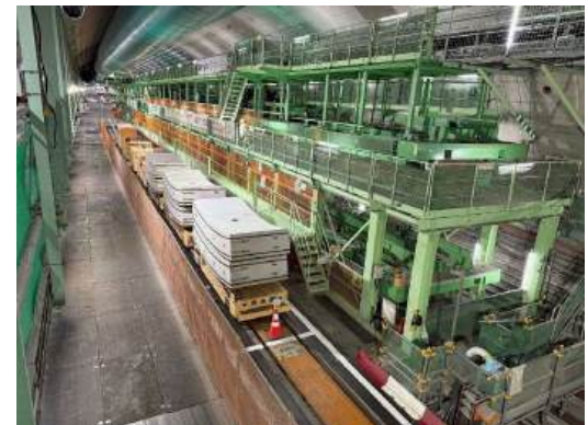
セグメント搬送状況 (令和7年7月25日)
