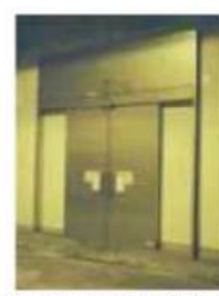
首都高速中央環状新宿線の例
