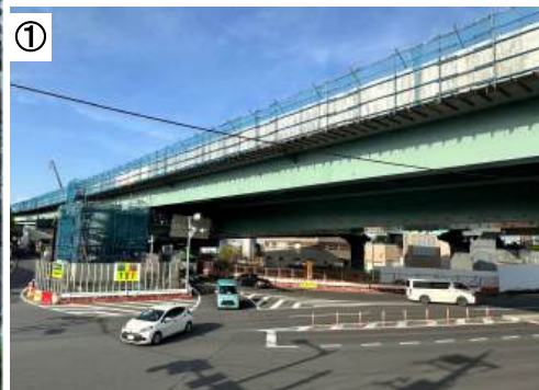
送出し架設後 (令和6年4月)
