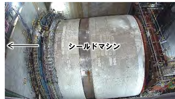
発進立坑部の状況 (令和6年9月18日)
