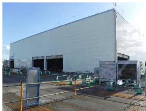
土砂ピットヤードの状況 (令和6年11月29日)
