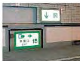
路面下への非常口(路面から)
