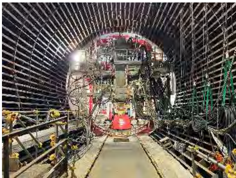
シールドマシン後方の状況 (令和6年11月20日)
