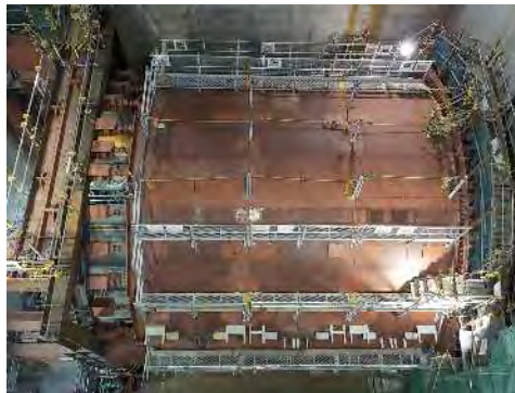
発進立坑部の状況 (令和6年11月25日)
