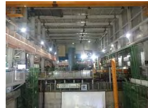
防音ハウス内の状況 (令和6年11月29日)
