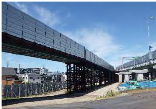
中央道へアクセスする工事用仮橋設置状況 (外景) (令和元年6月17日)
