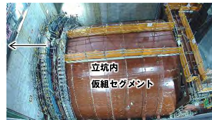
発進立坑部の状況 (令和6年11月20日)
