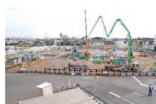
中央JCT南側開削トンネル施工状況(地上部) (令和6年10月31日)
