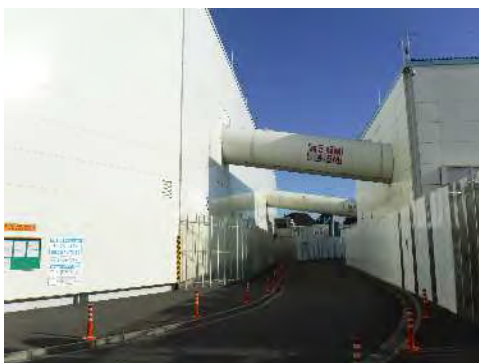
ベルトコンベアの状況 (令和6年11月29日)
