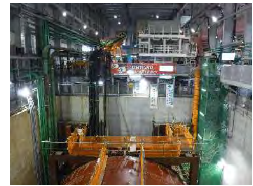
防音ハウス内の状況 (令和6年11月29日)
