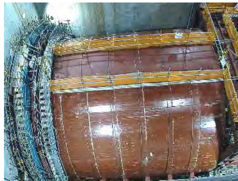
発進立坑部の状況 (令和6年11月20日)
