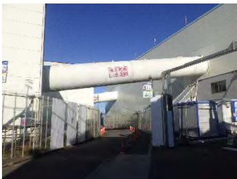
ベルトコンベアの状況 (令和6年11月29日)
