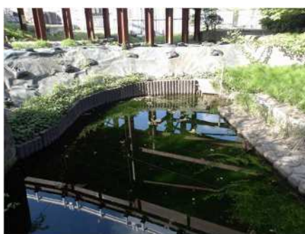
土砂流入防止措置の状況 (R6.4)
