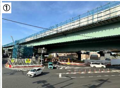
送出し架設後 (令和6年4月)
