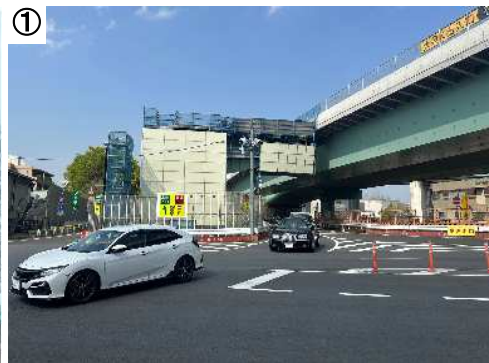
送出し架設前 (令和5年4月)
