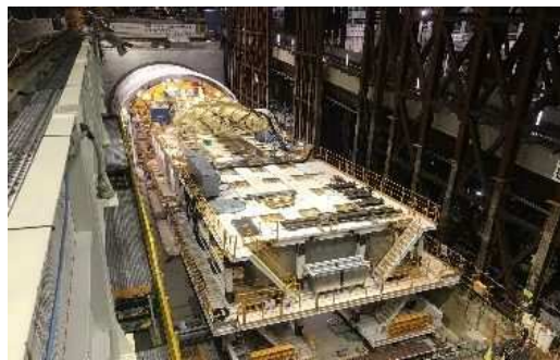
シールドマシンの後続台車の組立状況 (平成30年10月25日)
