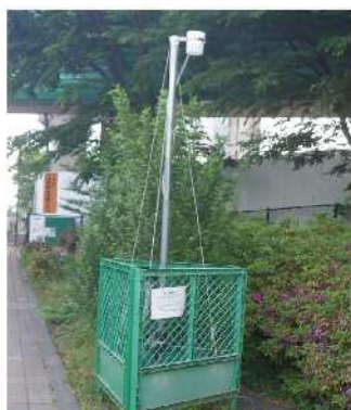
大気質(粉じん等)測定状況
