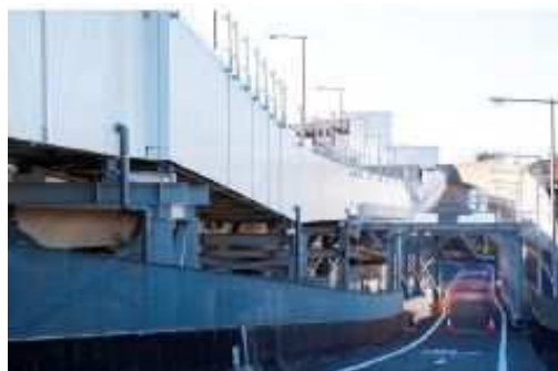
外環道のベルトコンベアの設置が完了した状況 (令和元年5月14日)
