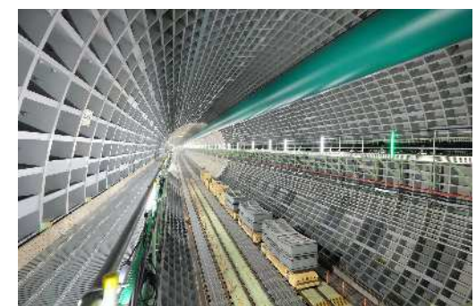
セグメント搬送状況 (令和6年8月21日)
