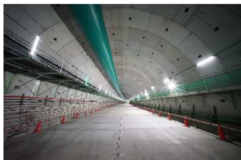
床版構築状況 (令和5年11月21日)
