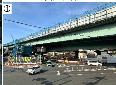
送出し架設後 (令和6年4月)
