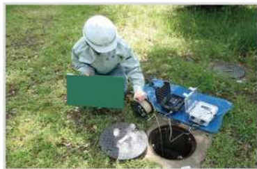
地下水位の観測状況
