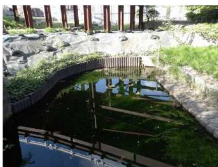
土砂流入防止措置の状況 (R6.4)
