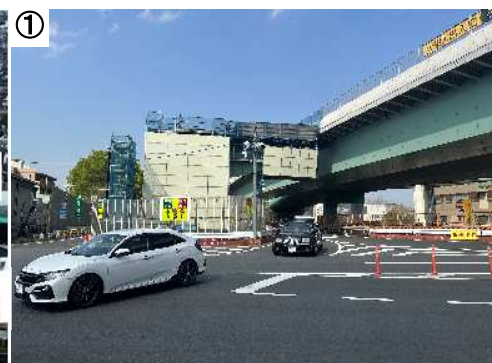
送出し架設前 (令和5年4月)
