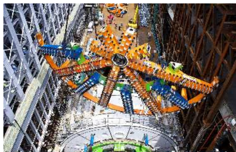
シールドマシンカッター部の投入・組立を行っている状況 (平成30年6月22日)
