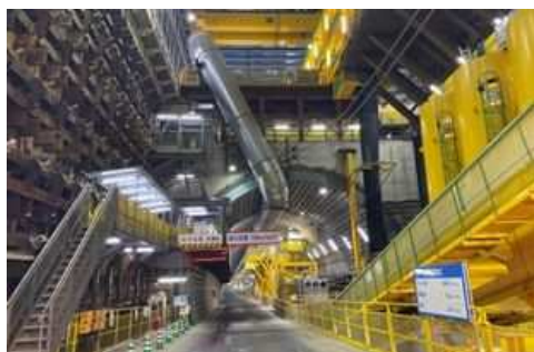
発進立坑部の状況 (令和6年3月26日)
