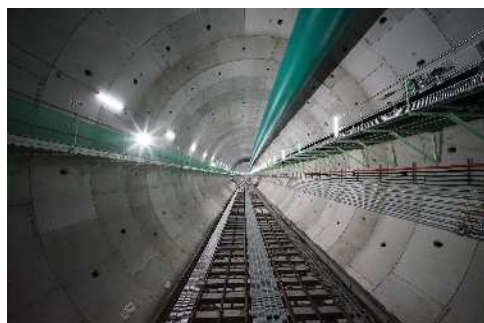
構築されたトンネル内(RCセグメント) (令和6年2月10日)
