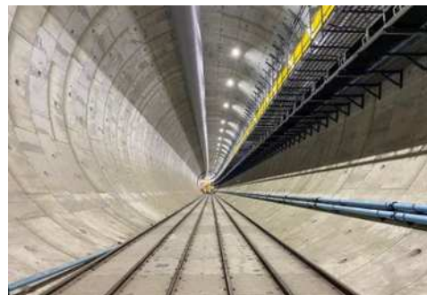
構築されたトンネル内(RCセグメント) (令和6年3月26日)
