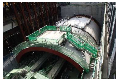
シールドマシン組立完了状況 (平成31年1月27日)
