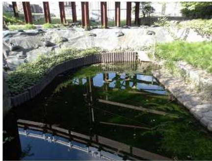
土砂流入防止措置の状況 (R6.4)
