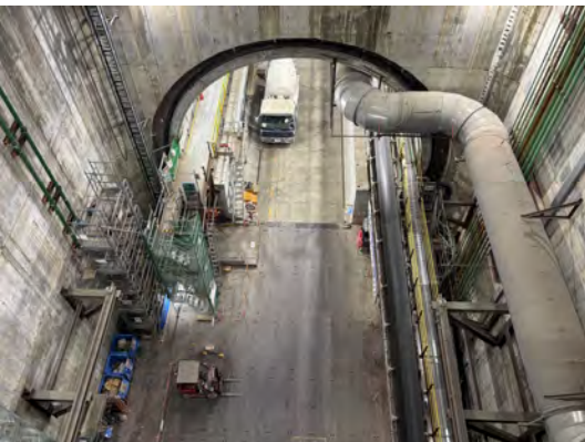
発進立坑部の状況 (令和7年12月3日)
