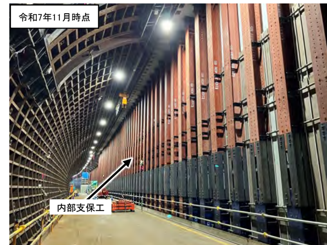
現場施工状況(東名JCT 地中拡幅(南行)工事)
