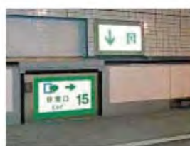
路面下への非常口(路面から)
