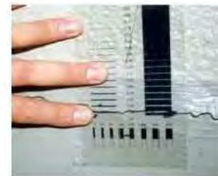
例: 亀裂損傷調査
