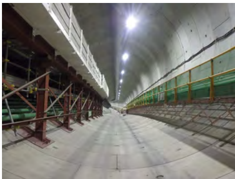
坑内の状況 (令和7年11月27日)
