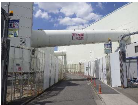
ベルトコンベアの状況 (令和7年7月30日)
