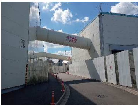
ベルトコンベアの状況 (令和7年7月30日)
