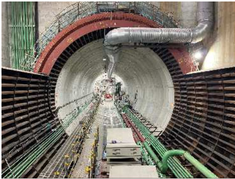
坑内の状況 (令和7年7月30日)
