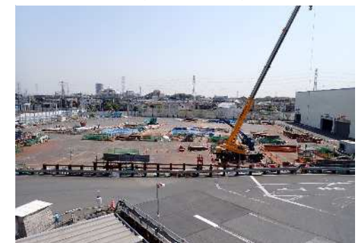
中央JCT南側開削トンネル施工状況（地上部） (令和7年4月17日)
