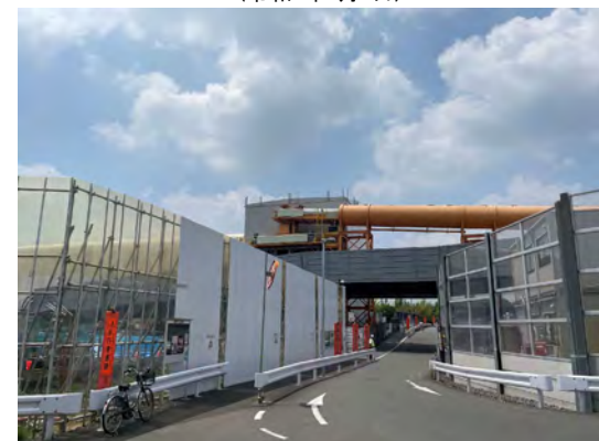
土砂ピットヤードの状況(世田谷通り方面から望む) (令和7年7月7日)
