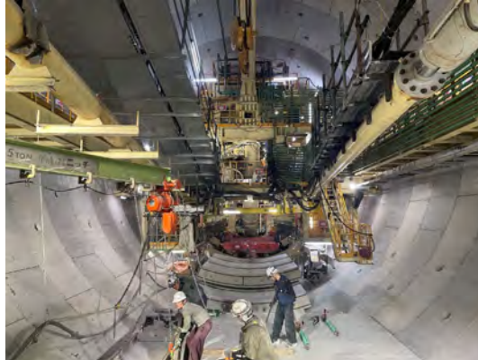
シールドマシンの状況 (令和7年7月7日)
