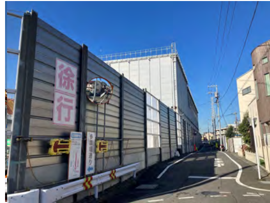
土砂ビットヤードの状況(世田谷通り方面から望む) (令和7年7月25日)
