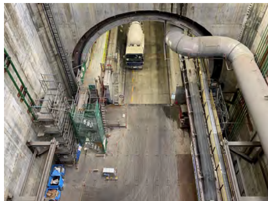
発進立坑部の状況 (令和7年7月23日)
