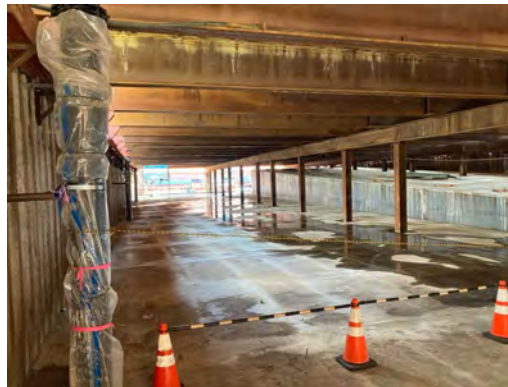
Hランプボックス構築の状況 (令和7年7月23日)
