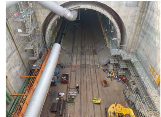
発進立坑部の状況 (令和7年7月7日)
