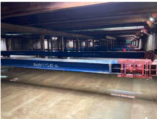
Hランプボックス構築の状況 (令和7年7月2日)
