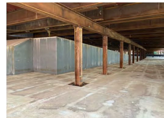
Hランプボックス構築の状況 (令和7年7月23日)
