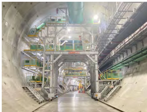
シールドマシンの状況 (令和7年7月1日)
