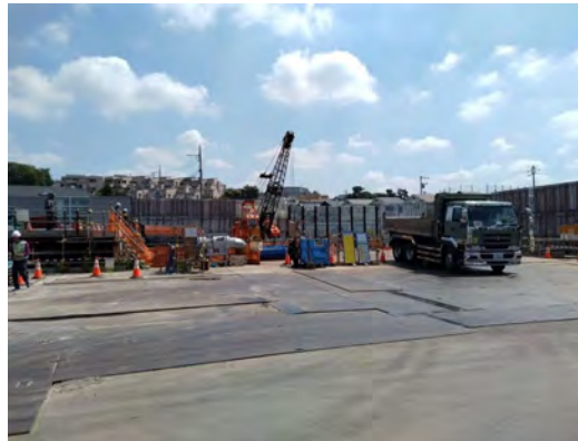
Hランプ工事 大正橋付近から北西方向を望む (令和7年7月23日)
