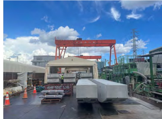
セグメントストックヤードの状況 (令和7年7月7日)
