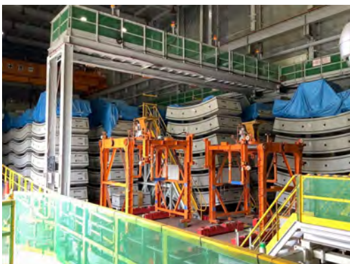
セグメントストックヤードの状況 (令和7年7月1日)
