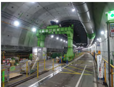
トンネル内の資材投入設備の状況 (令和7年7月23日)
