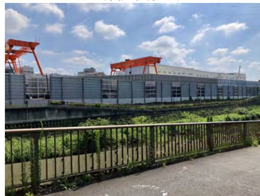
土砂ビットヤードの状況(野川側から望む) (令和7年7月23日)
