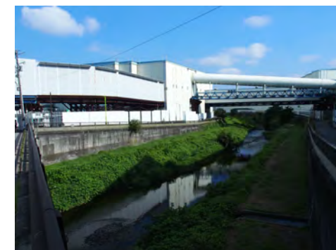
土砂ピットヤードの全景写真 (令和7年7月23日)
