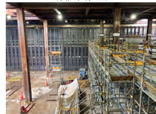
換気所地下工事の坑内 多摩堤通り側を望む (令和7年7月15日)
