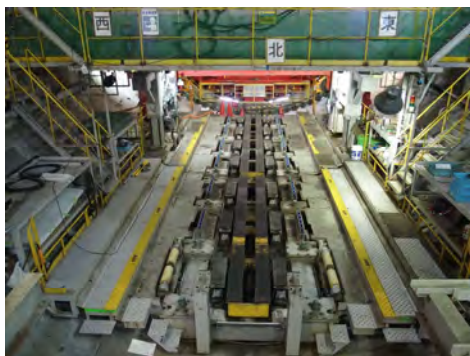
セグメントを供給する装置の状況 (令和7年7月23日)
