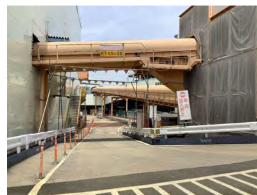
立坑地上部・連続ベルトコンベア (令和7年7月1日)
