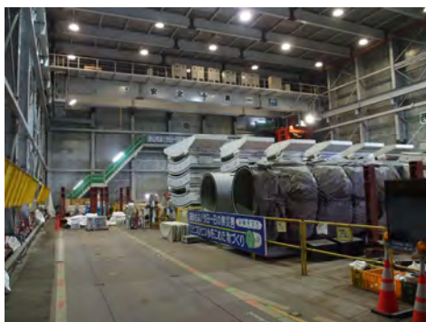
セグメントストックヤードの状況 (令和7年7月23日)
