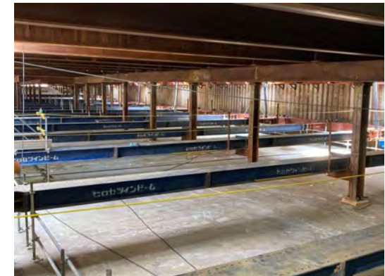
Hランプボックス構築の状況 (令和7年7月2日)
