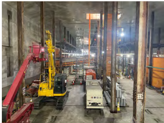
シールドマシン後方設備の状況 (令和7年7月7日)
