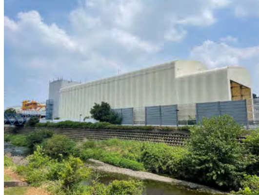
土砂ピットヤードの状況(野川側から望む) (令和7年7月7日)
