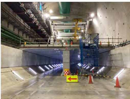
内部構築工・床版設置状況 (令和7年7月1日)
