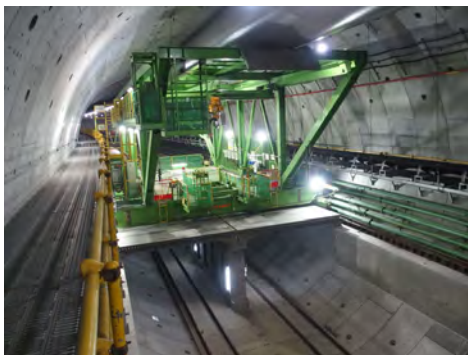
トンネル内の内部構築施工設備の状況 (令和7年7月23日)
