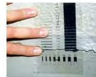
例: 亀裂損傷調査
