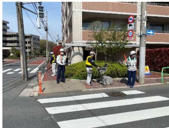
路面下空洞調査(歩道部)
