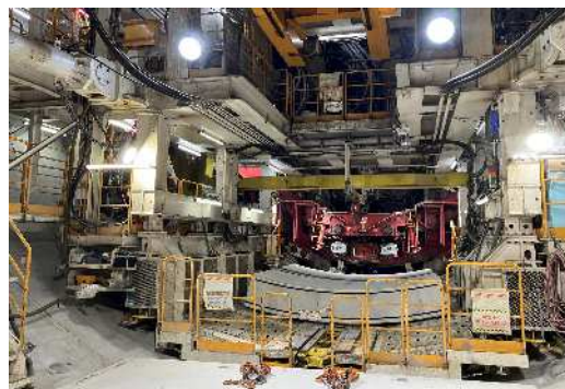
掘進状況 (令和7年7月25日)
