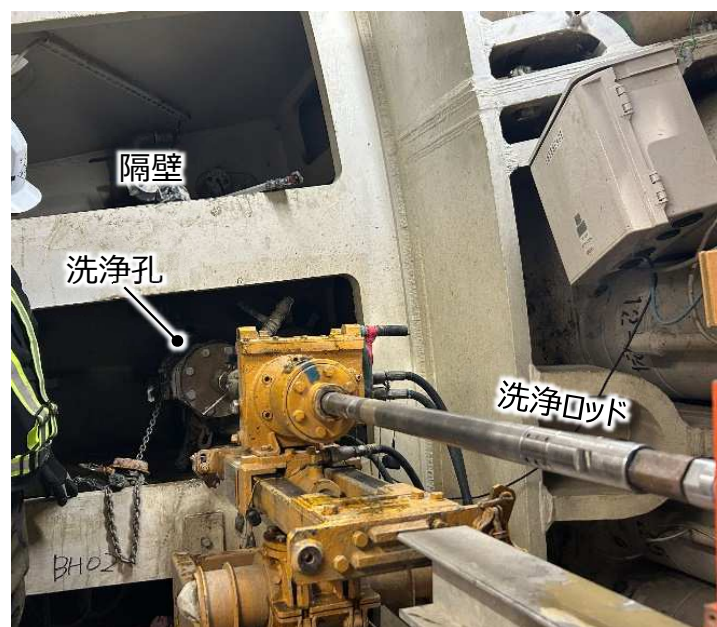
高圧洗浄の作業状況
