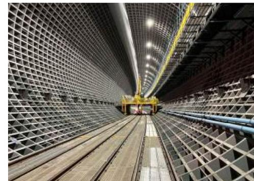
構築されたトンネル内(鋼製セグメント)
