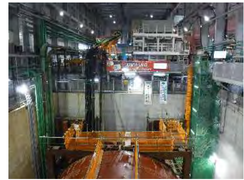
防音ハウス内の状況 (令和6年11月29日)
