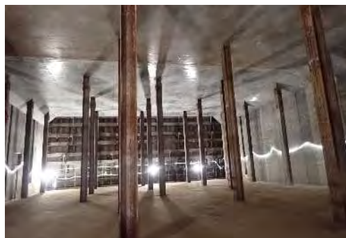
中央JCT南側開削トンネル施工状況 (令和5年12月20日)
