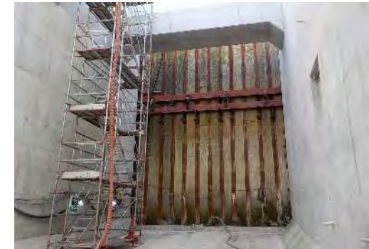
中央JCT北側開削トンネル施工状況 (令和5年2月1日)
