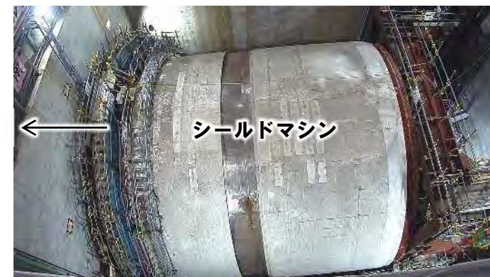
発進立坑部の状況 (令和6年9月18日)
