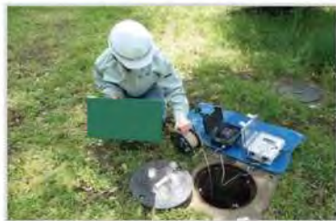
地下水位の観測状況
