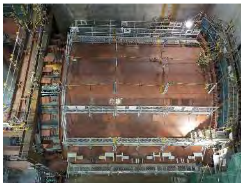
発進立坑部の状況 (令和6年11月25日)
