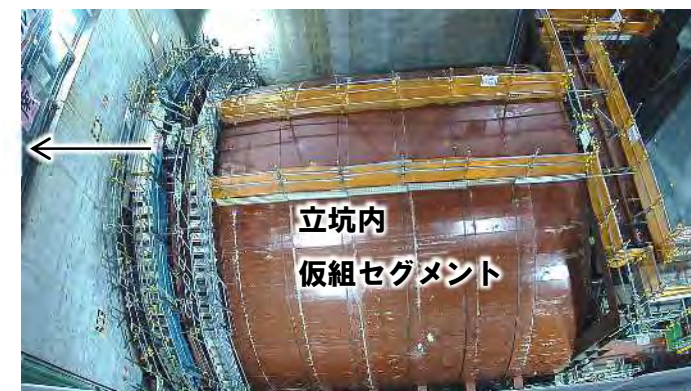
発進立坑部の状況 (令和6年11月20日)
