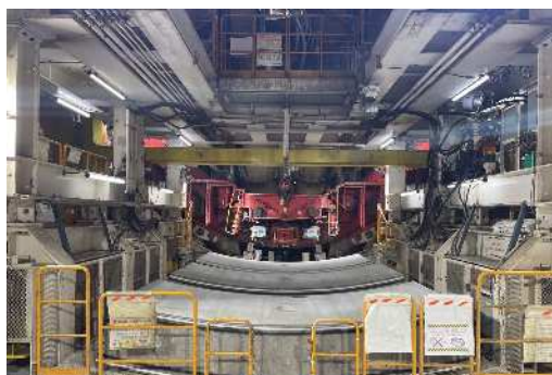
掘進状況 (令和6年9月30日)
