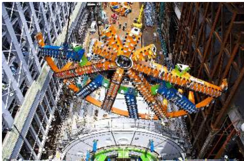
シールドマシンカッター部の投入・組立を行っている状況 (平成30年6月22日)
