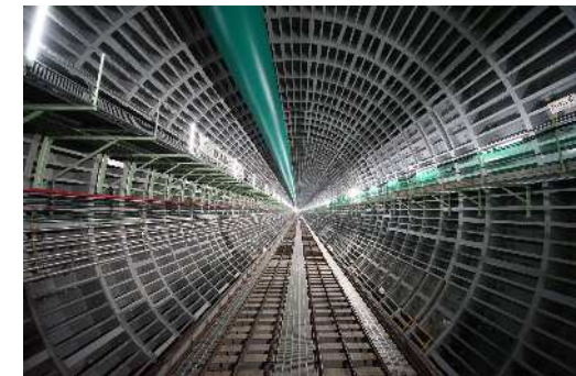
構築されたトンネル内(鋼製セグメント) (令和6年10月7日)
