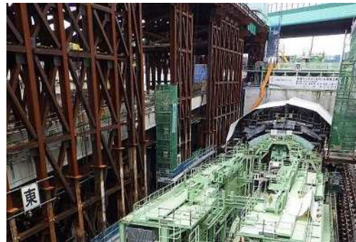
シールドマシンの後続台車の組立状況 (平成30年9月18日)
