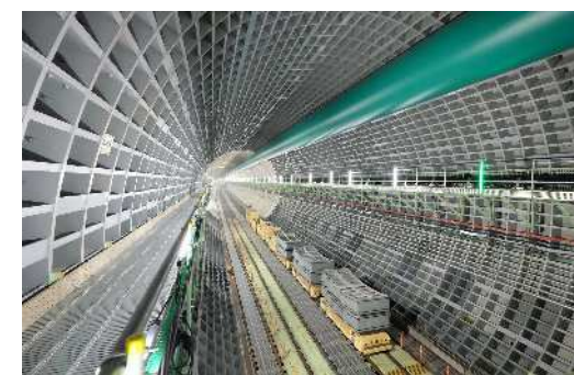
セグメント搬送状況 (令和6年8月21日)
