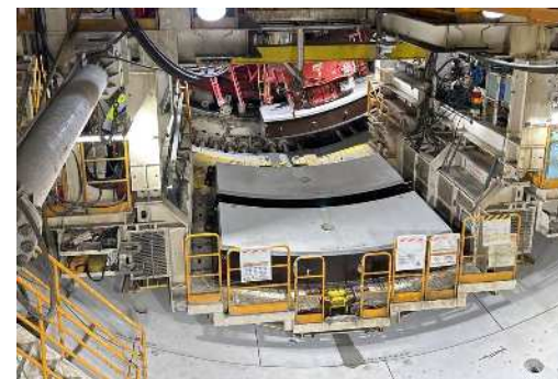
セグメント組立状況 (令和6年11月12日)
