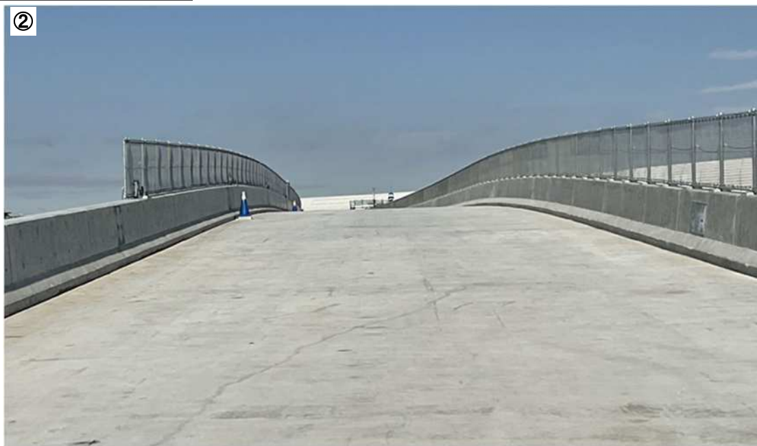
橋りょう上部の鉄筋コンクリート製床版の状況 (令和6年11月)
