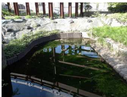
土砂流入防止措置の状況 (R6.4)
