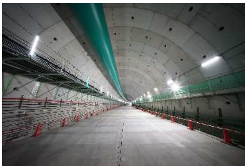
床版構築状況 (令和5年11月21日)
