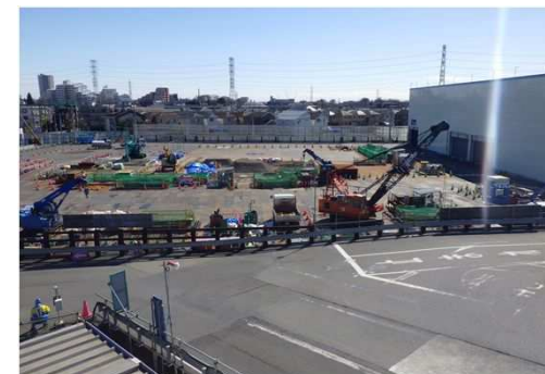
中央JCT南側開削トンネル施工状況 (地上部) (令和6年2月28日)
