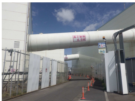
ベルトコンベアの状況 (令和6年4月16日)
