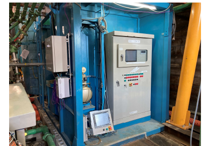
鋳物系添加材用泥水タンク
