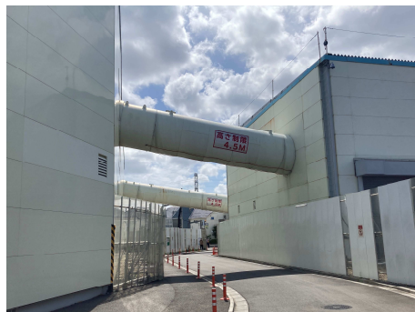
ベルトコンベアの状況 (令和6年4月16日)
