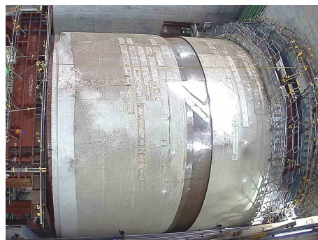
発進立坑部の状況 (令和6年4月16日)
