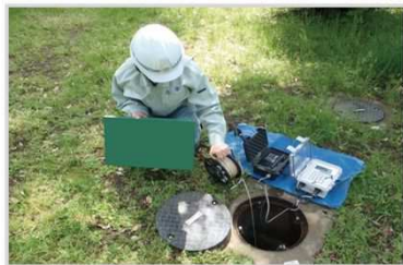
地下水位の観測状況
