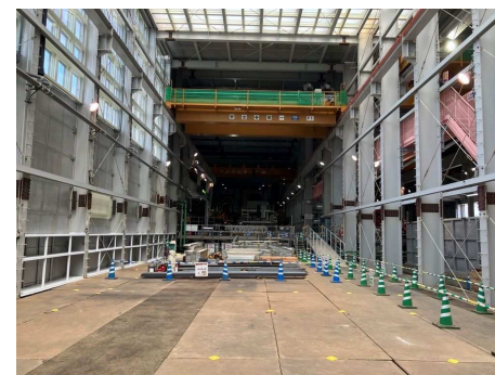
セグメントストックヤードの状況 (令和6年4月16日)
