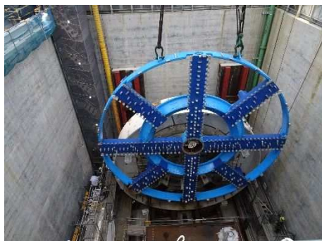
シールドマシンの組立状況 (平成30年12月11日)
