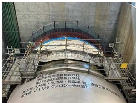
シールドマシン発進前の状況 (令和5年1月20日)
