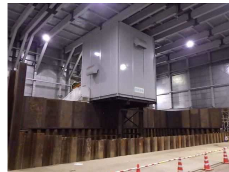
土砂ピットヤード内部の状況 (令和6年4月16日)
