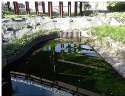
土砂流入防止措置の状況 (R6.4)
