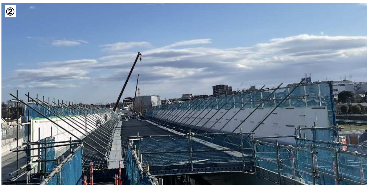
橋りょう上部の鉄筋コンクリート製床版の工事状況 (令和6年2月)
