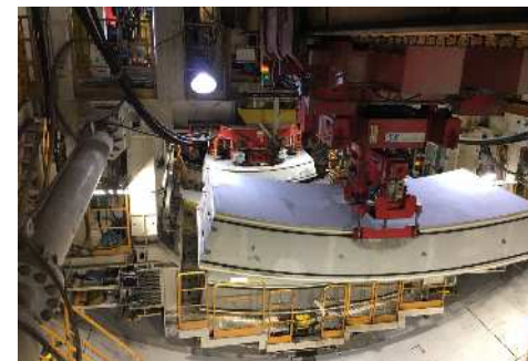
セグメント組立状況 (令和6年4月11日)
