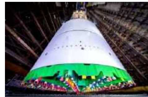
シールドマシン組立状況の前景写真 (平成30年10月25日)
