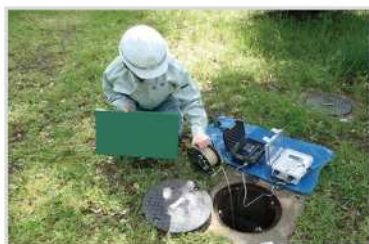
地下水位の観測状況
