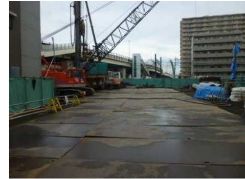
施工基面の養生(鉄板)
