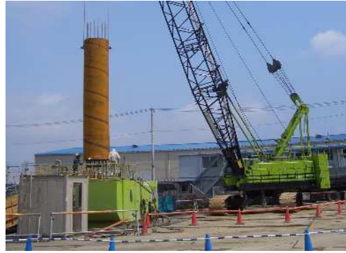
重機(クローラクレーン)
