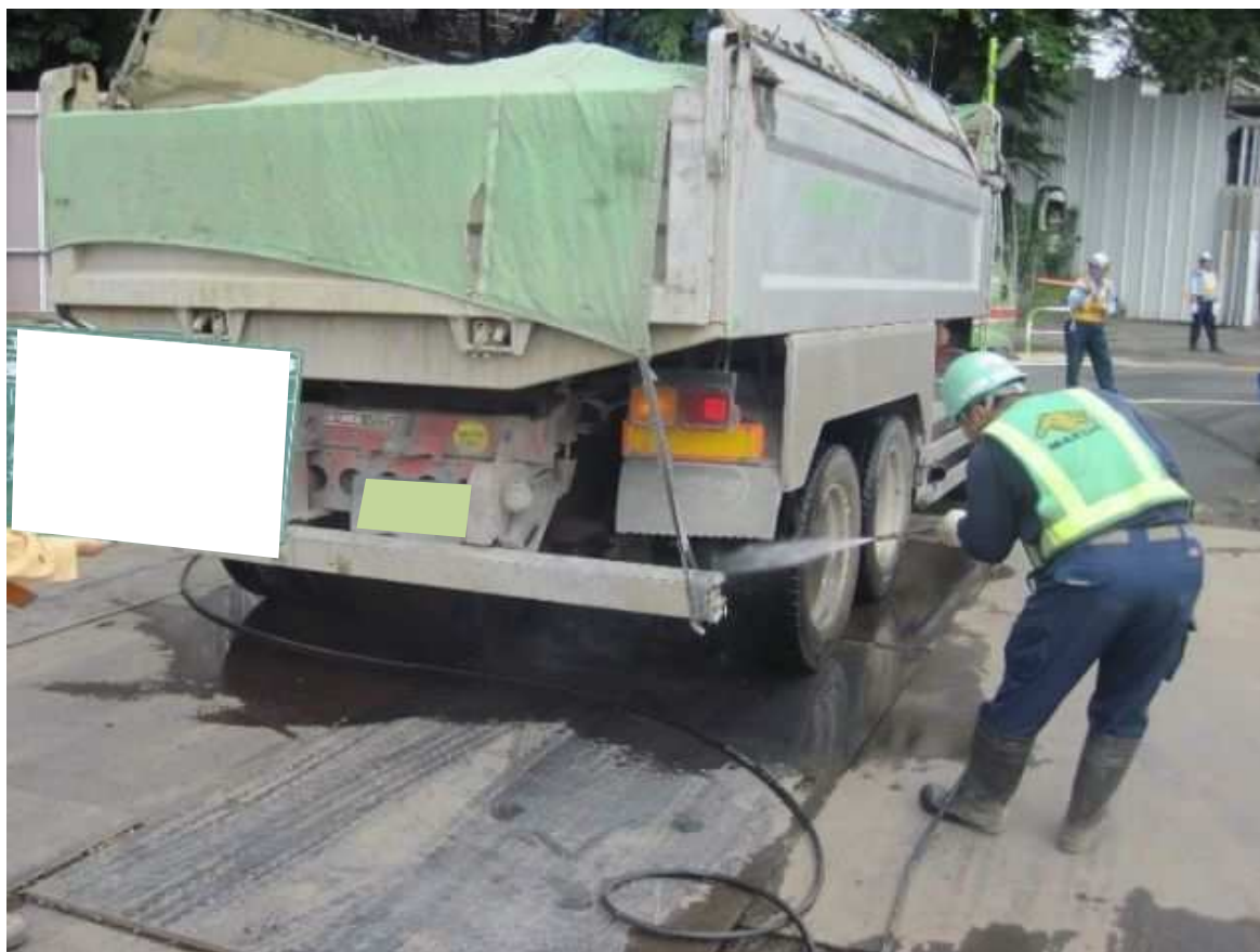
ダンプトラックのタイヤ清掃状況
