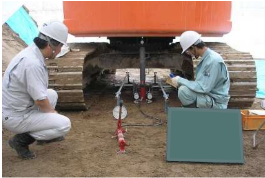
地盤の確認(地耐力測定)
