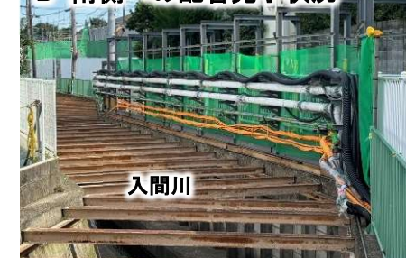
B 南側への配管完了状況
