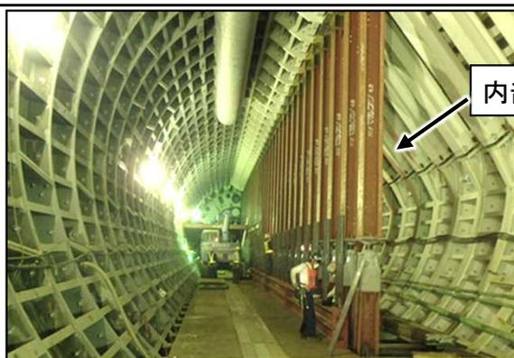
※内部支保工:トンネルを拡幅したときに、既存のシールドトンネルが変形しないように上下方向に設置するH型鋼の柱。
