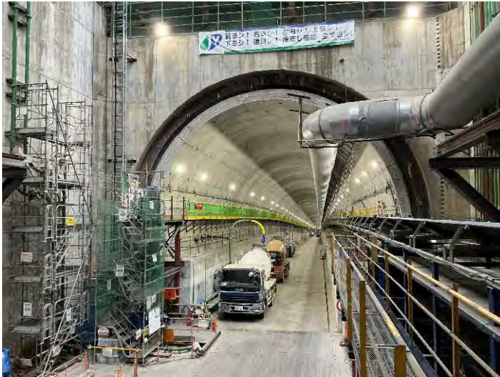
Hランプ坑口
