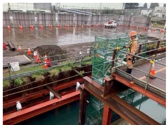
＜土留壁の監視状況＞
