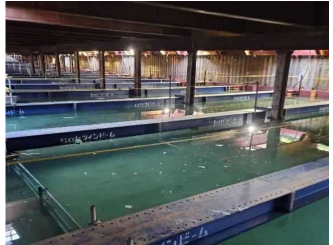
＜函体側空間への注水状況＞
