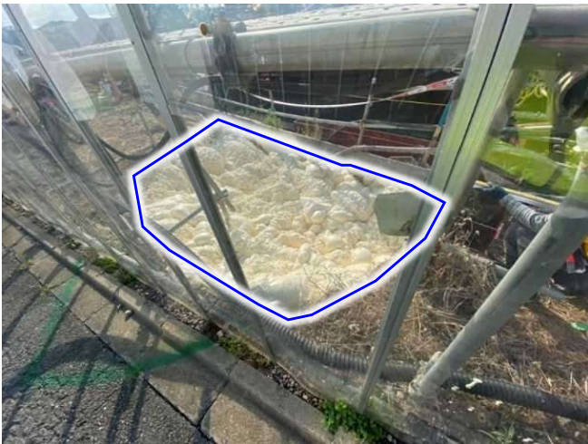
＜地表面変状の埋め戻し状況＞
