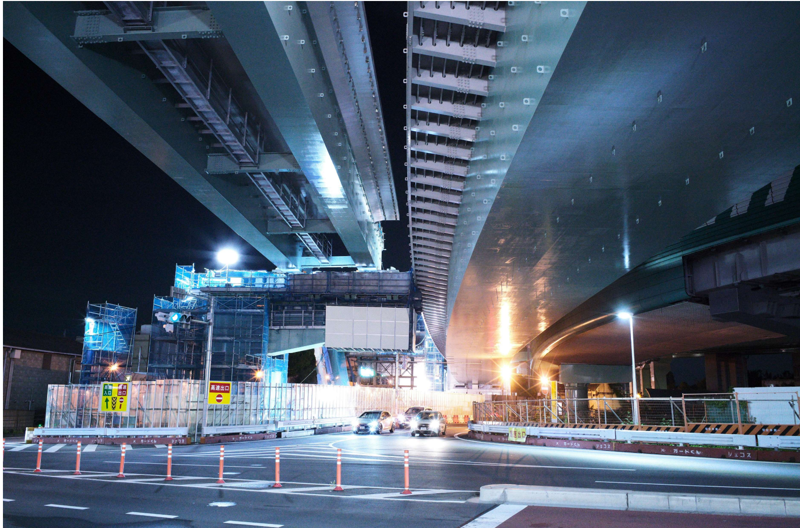
目白通り上空を交差する橋りょうの架設工事の様子 (9月4日)
