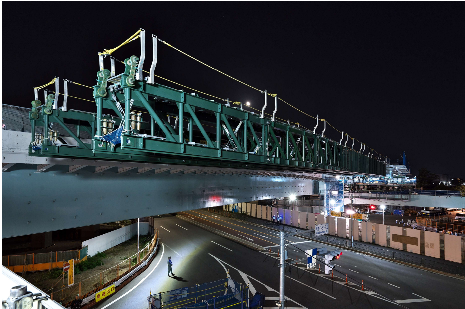
目白通り上空を交差する橋りょうの架設工事の様子 (4月10日)
