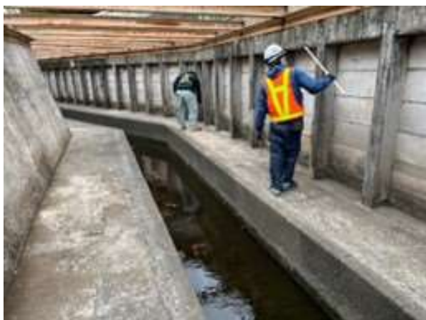
変状調査（点検）
