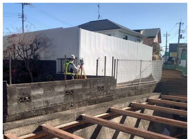
変状調査（測量）
